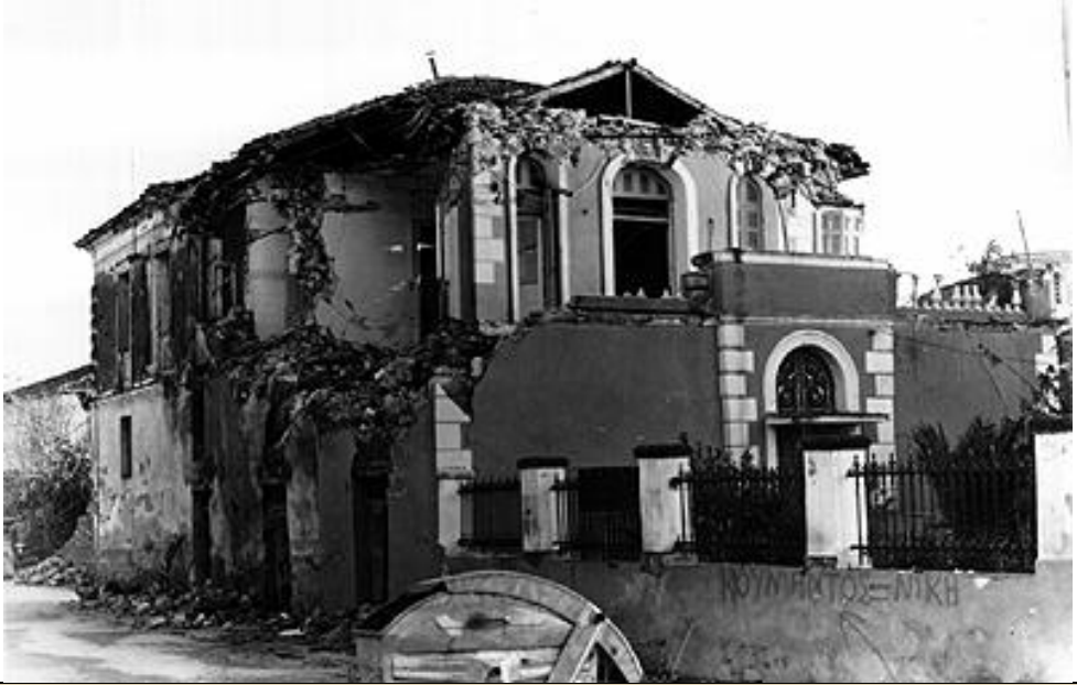
الصورة 31: شدة الضرر - انهيار جزئي "أحمر" -
