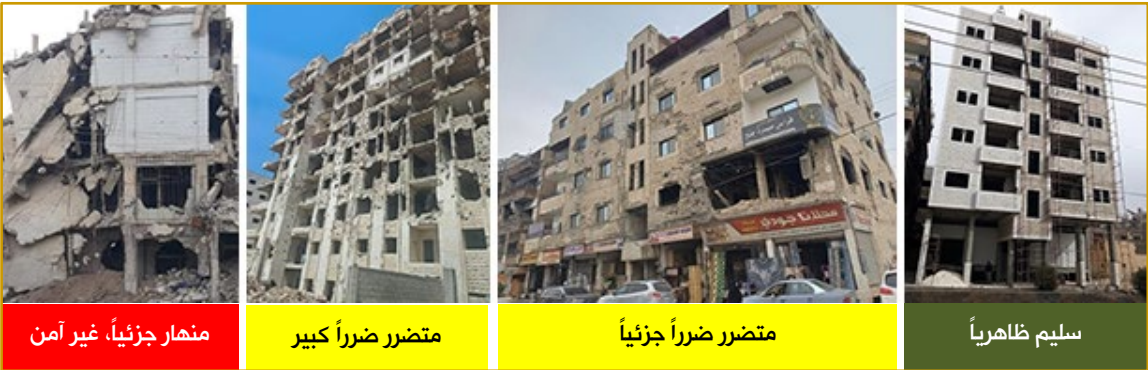
الشكل 92: مباني في داريا "ريف دمشق" تعطي أمثلة عن وصف الضرر.
