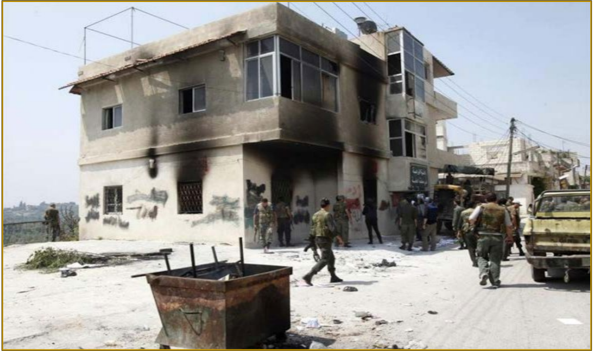
الشكل 05: نموذج لأضرار الحرائق في المباني السورية.
