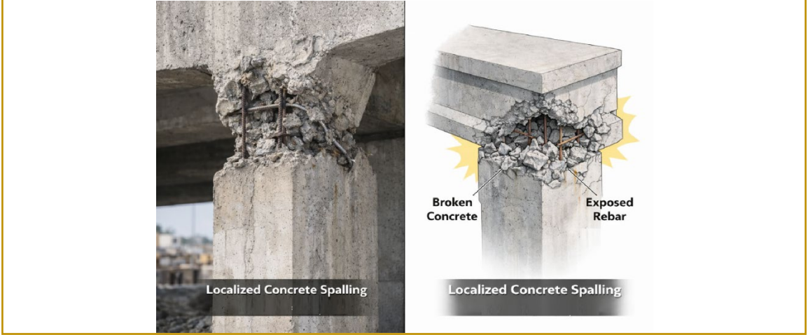
الشكل 84: صورة تبيّن تهشّم موضعي للخرسانة.
